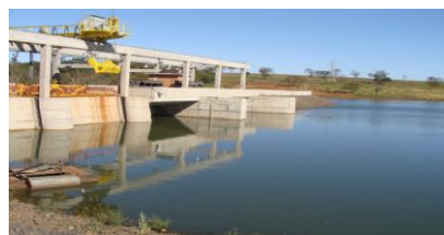
Vista da Barragem e Reservatório - (Lago)
