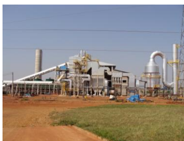
Vista Panorâmica -Termelétrica em Construção
